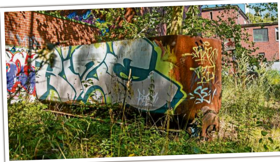
Stillgelegte Industrieanlagen und Gebäude stehen auf dem Zechengelände der RAG.
